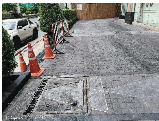
บ่อ Man Hole ที่ใช้เป็นระบบบ่อหน่วงน้ำ
