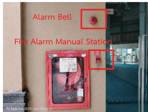
Alarm Bell และ(Fire Alarm Manual Station)
