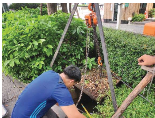
เจ้าหน้าที่ตรวจสอบตะกอนในบ่อ บ่อ Man Hole
