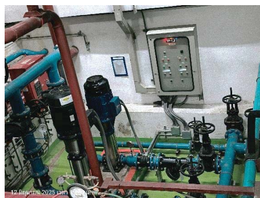
ปั๊มสูบน้ำ ขึ้นไปยังถังเก็บน้ำชั้นหลังคา
